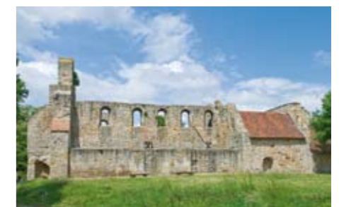
RUINE DER STIFTSKIRCHE ST. MARIEN IN WALBECK Bemerkenswert hier das originale Mauerwerk aus ottonischer Zeit.
